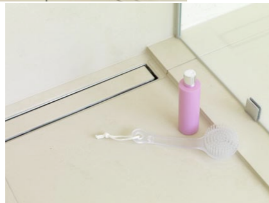
Der Blick von der Wanne und dem minimal abgetrennten Duschbereich zum Kosmetikplatz mit Wengé furnierten Schränken. Im Detail (rechts): Die Dusche hat eine dezente Ablaufrinne, deren Abdeckung mit dem Fliesenmaterial des Bodens kaschiert ist. Hersteller, Adressen am Heftende
